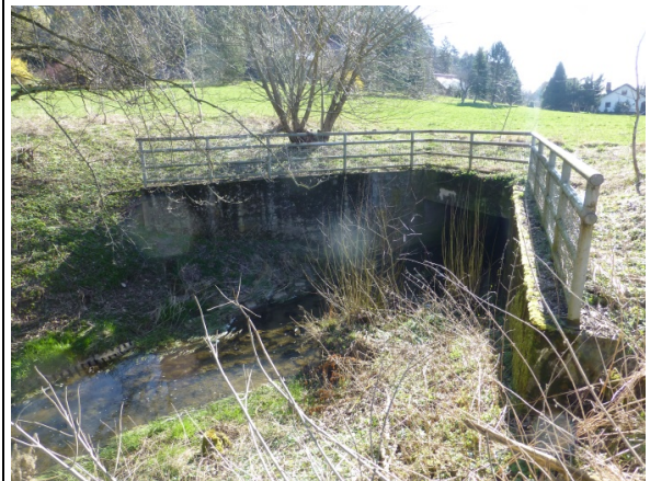
Austritt des Mühlbachs aus der Verdolung, Fundort des Mausohrs und Wasserfledermaus („Mühlbachkanal“)
