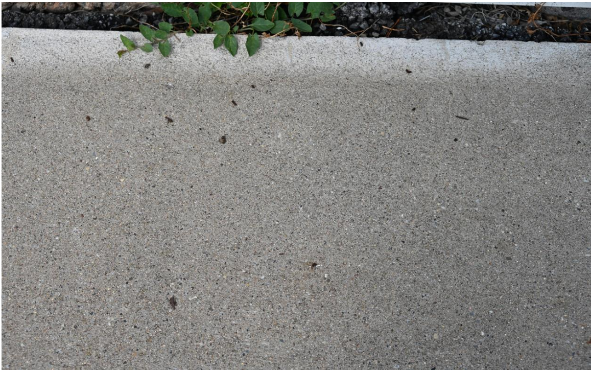
Abbildung 3: Befundlage am 31.08.2022 an der Südseite des Gebäudes Mühlbachstraße 28 mit Kotspuren der Bartfledermaus.
