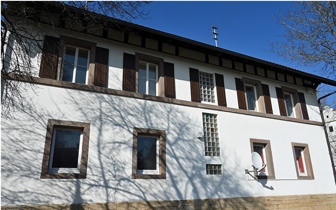
Abb. Anhang IA-4: Fest montierte Scheinfensterläden als Fledermausquartier.
