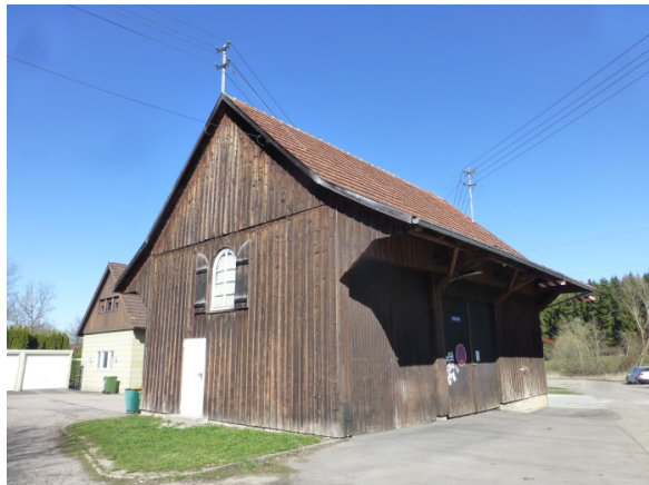
Lagergebäude / Holzscheune Mühlbachstraße 28, Fundort Wochenstube Bartfledermaus und Kolonie Zwergfledermaus
