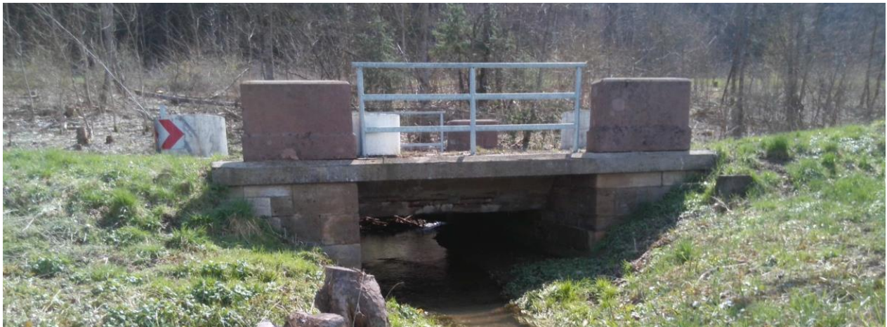
Abbildung 4-4 Photo der Brücke „alte B27“ (gegen die Fließrichtung“)
