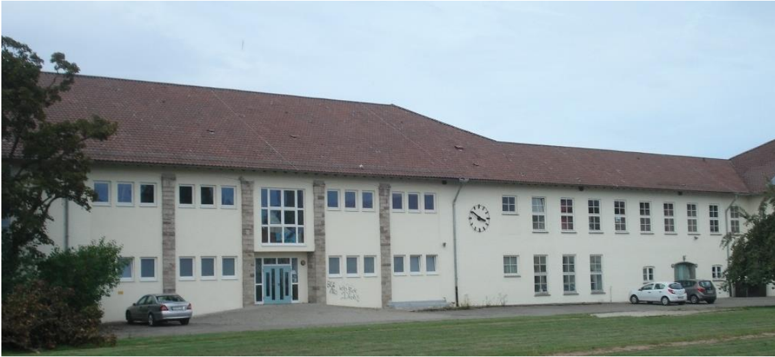
Abbildung 39: Außenansicht der Friedensschule
