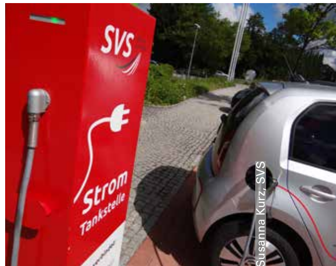
E-Ladesäule am Landratsamt
